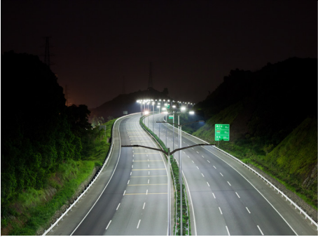
◀ 深高速公路LED照明工程
