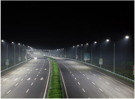
南京机场高速LED照明工程 ▶
