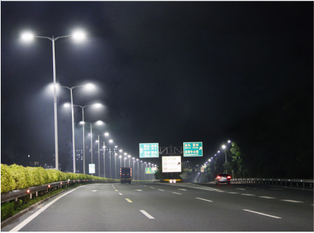
▲ 清平高速LED照明工程
